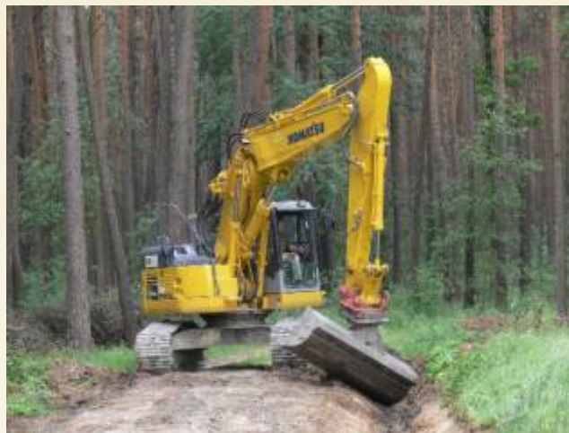
Herstellung des Rohplanums
